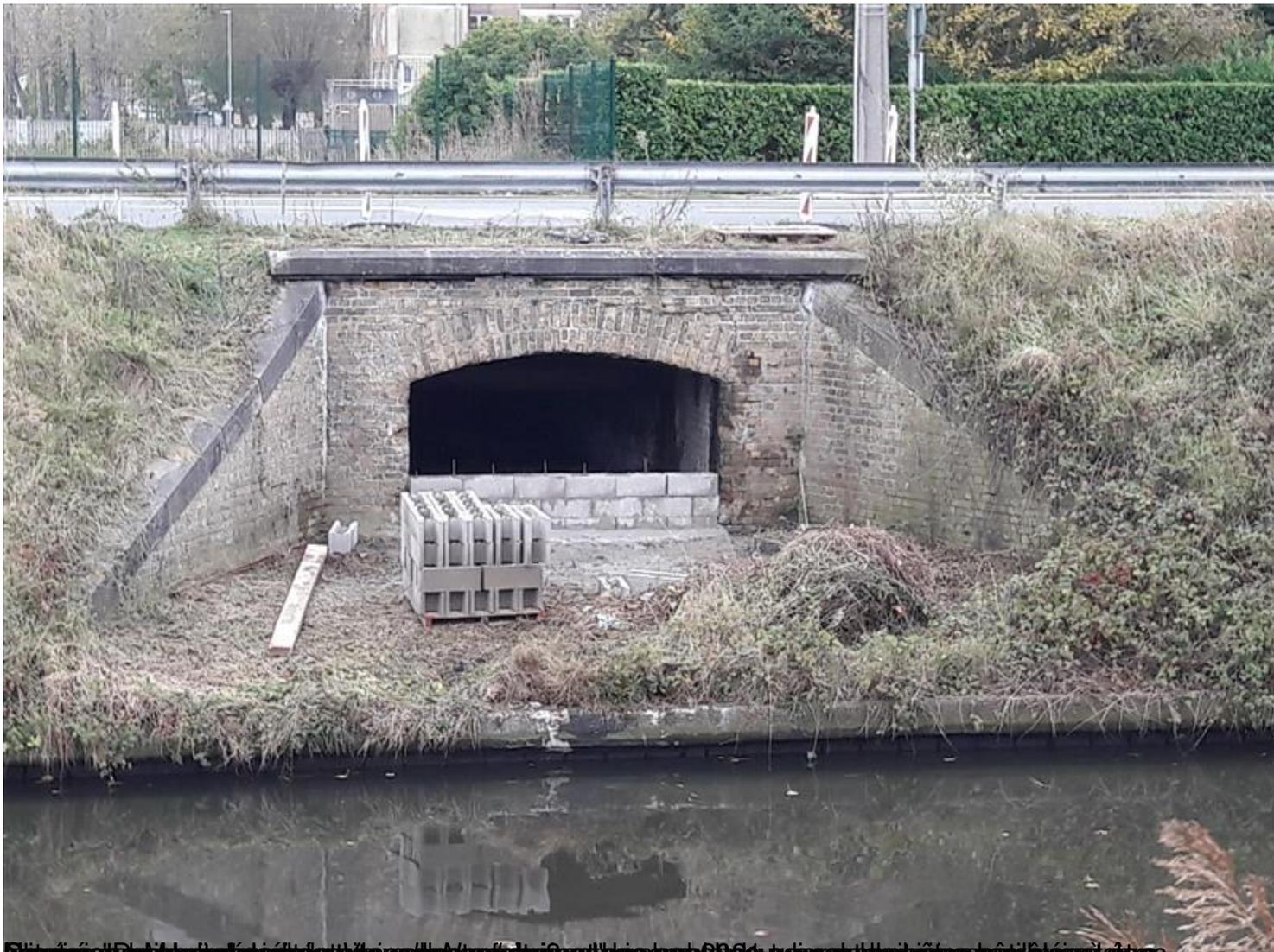
Structure de drainage en brique et parpaing. Le parpaing est un matériau de construction en béton qui remplace la brique dans les ouvrages de drainage.
